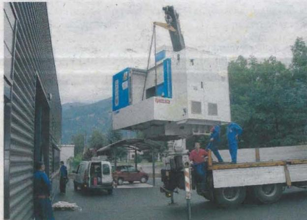
Thyez, lundi 21 juin. Le centre d'usinage Huron KX8 du CFAI est déchargé du camion avant d'être installé dans le nouvel atelier.
